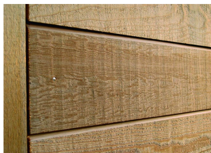
Afbeelding 1 Voorbeeld open gevelbekleding
